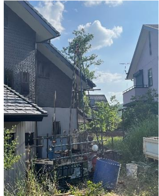
ボーリング調査状況
